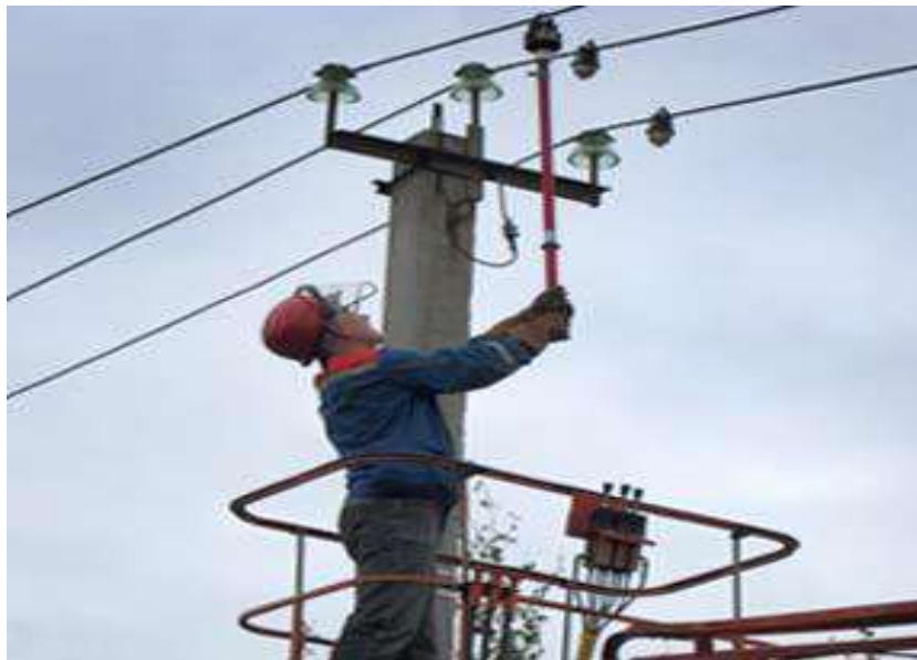
Рисунок 6 – Монтаж топографических индикаторов на провода ВЛЭП 10 кВ
